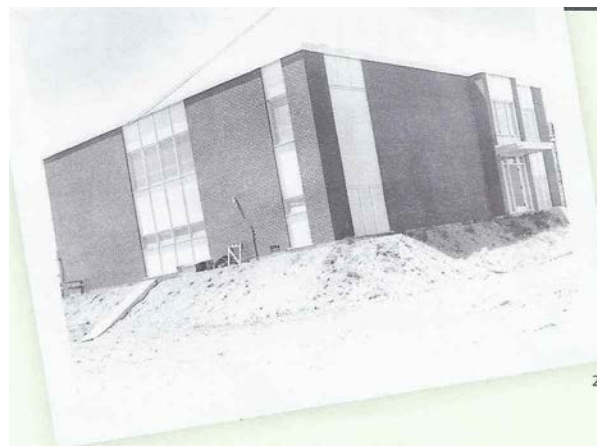
2 / Le bâtiment de commande tel qu'il a été construit, il y a environ 50 ans.
